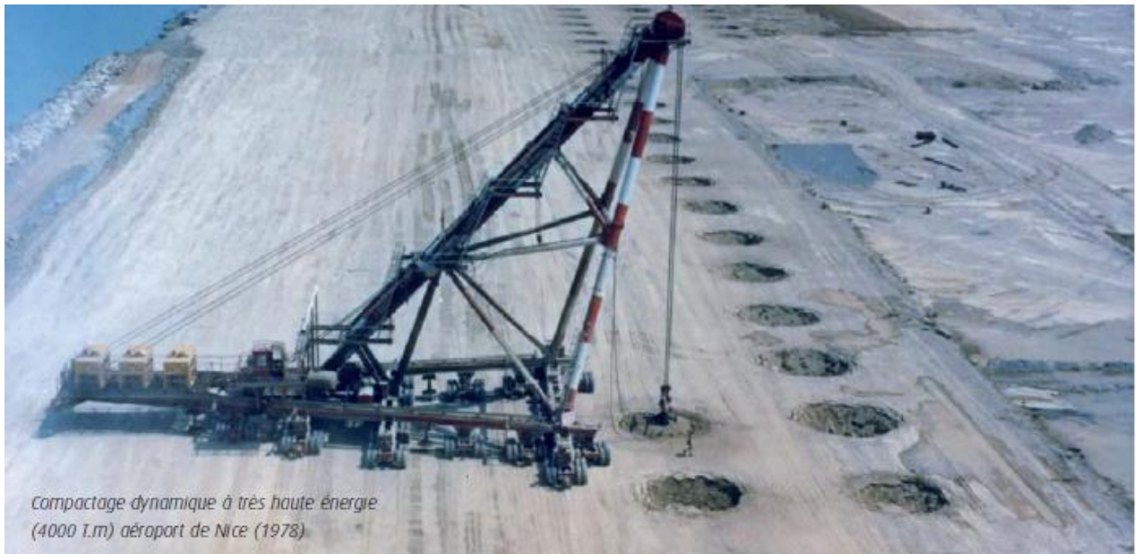
Fig. III.3 — Densification d'un terrain par compactage dynamique à très haute énergie (4000 T.m) (Cas réel de l'aéroport de Nice 1978, France).
