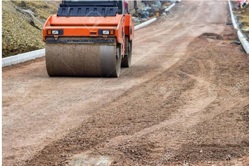
**Fig. III.2** — Compactage de surface aux références de compactages d'une chaussée routière.
